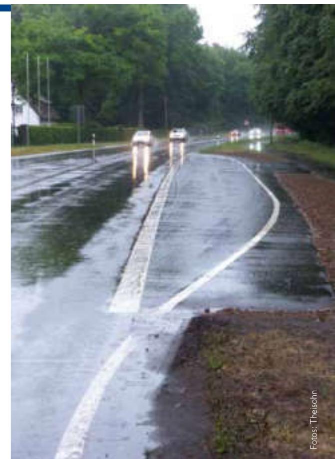
Leider nur in Richtung Flughafen fertig gestellte Haltebucht der Buslinie 423 (Wasserstoff-Bus)
